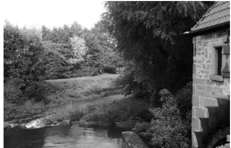
Bedingt durch die Nachbesserungsarbeiten des Kreises Steinfurt bei der Einleitung in die Fischtreppe (zusätzlicher Wasserstau durch größere Steinbrocken) ist in Höhe des Gartens hinter der Niedermühle eine Halbinsel entstanden. Ergebnis: Das Wasserrad der Niedermühle steht ständig etwa 30 cm im Wasser.
